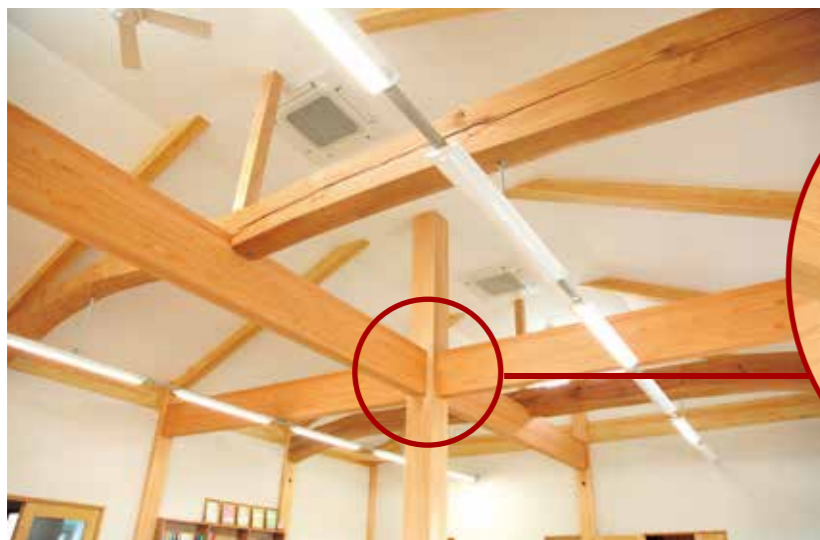
【施工事例】執務室梁
